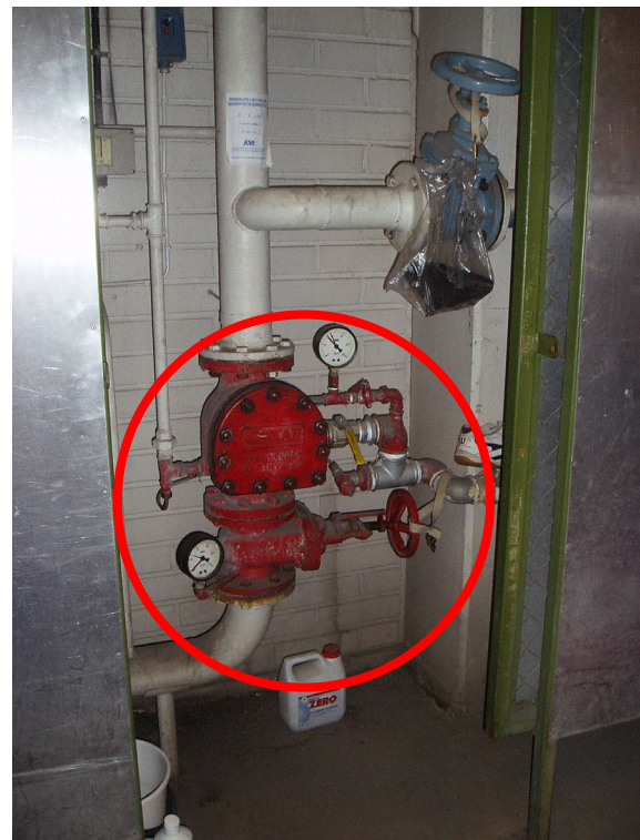
Kuva 5. Sprinklerkeskuksen pääsulkuventtiili.
