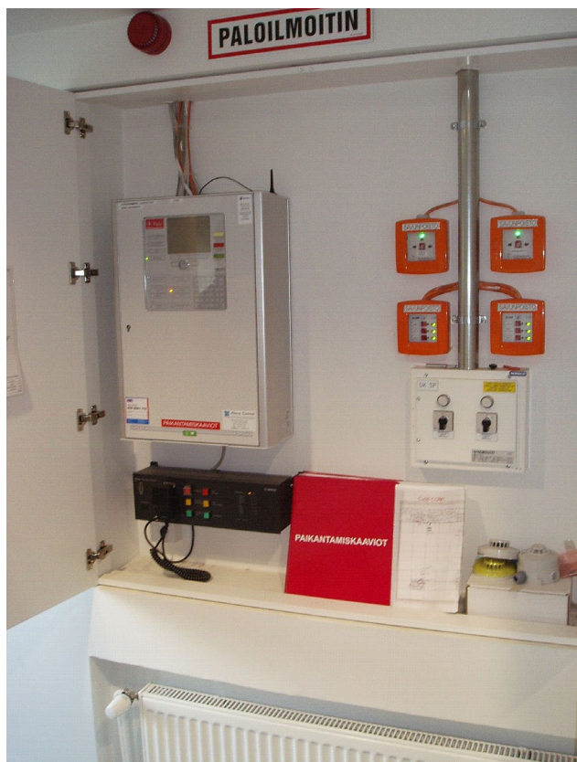
Kuva 2. Paloilmoittimen keskuslaitteiston alapuolella ovat paikantamiskaaviot ja oikealla puolella savunpoiston laukaisupainikkeet
