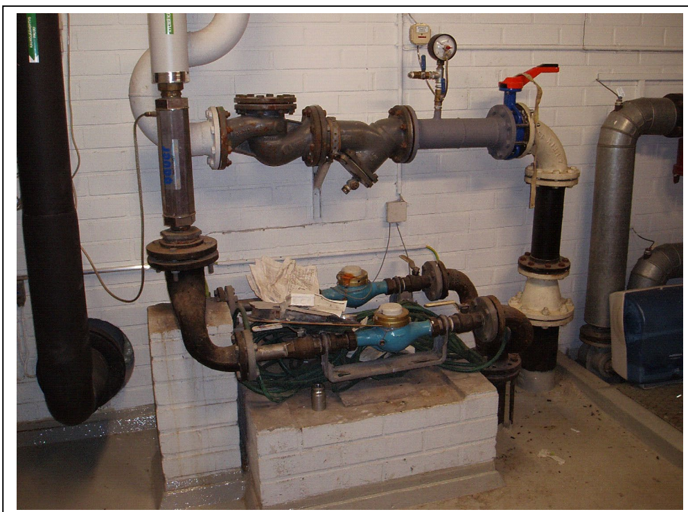
Kuva 11. kaukolämmön sulkuventtiilit lämmönjakohuoneessa.
