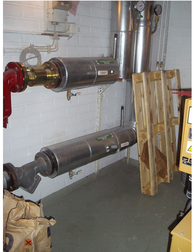
Kuva 11. kaukolämmön sulkuventtiilit lämmönjakohuoneessa.
