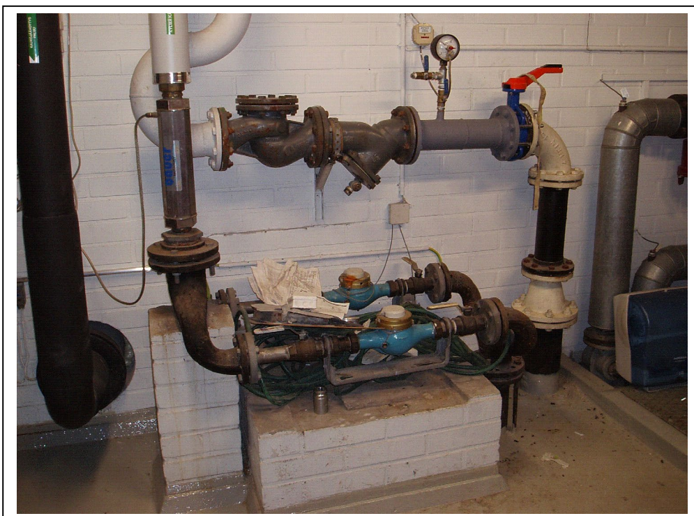
Kuva 11. kaukolämmön sulkuventtiilit lämmönjakohuoneessa.
