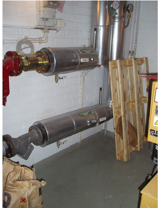
Kuva 11. kaukolämmön sulkuventtiilit lämmönjakohuoneessa.
