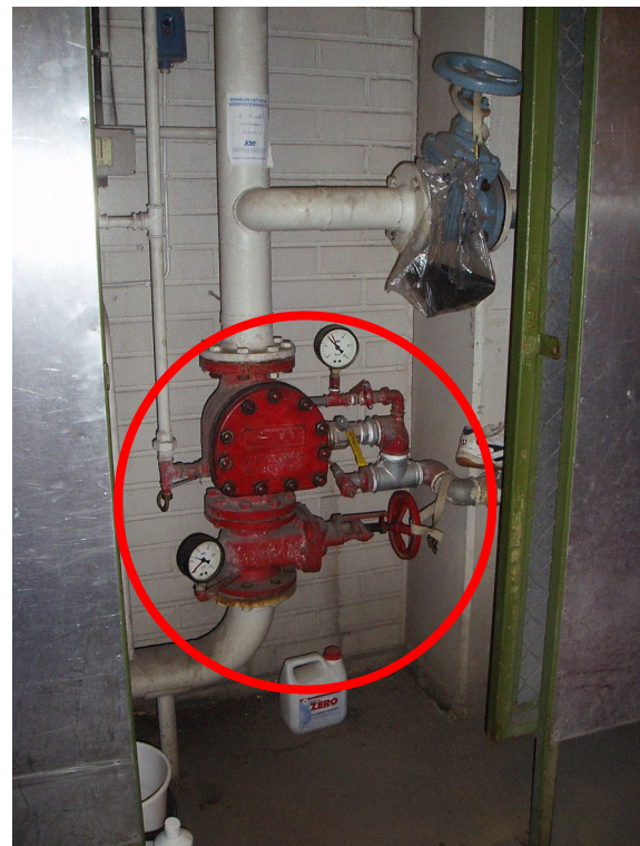
Kuva 5. Sprinklerkeskuksen pääsulkuventtiili.
